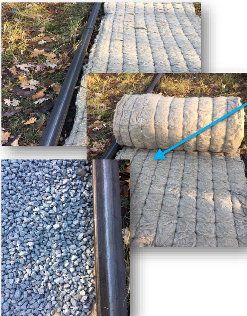
Почва на маневровых путях сильно загрязнена в результате множества мелких разливов нефтепродуктов из цистерн. Мы предлагаем решить проблему загрязнения. Настильный мат, сверху покрывается слоем щебня и улавливает все аварийные разливы
